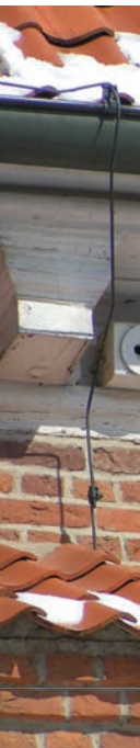
Nisthilfen für Mauersegler lassen sich auch in die gemauerte Fassade integrieren. Bei entsprechender Dämmkonstruktion entstehen keine bauphysikalischen Nachteile. (Detailzeichnungen: Architekten Schüch & Cassau BDA).
