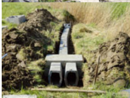
V. o. n. u.: Kiebitzgelege; Hans Funck beim Einbau der Verkabelung im Kunstbau; fertiger Kunstbau vor der Abdeckung mit Erde
