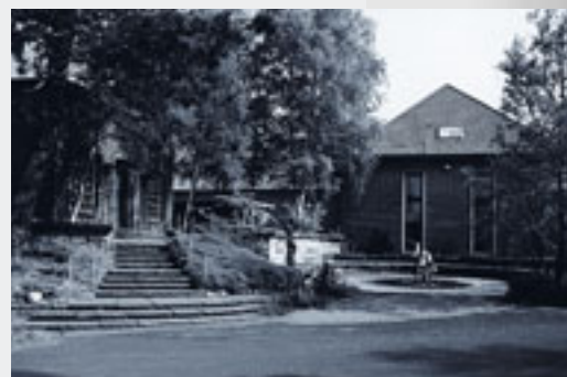
oben: Wasserwerk Himmelpforten
