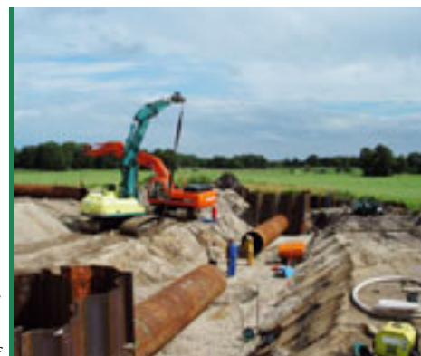
Oben: Bodenentnahmestelle Schönau Rechts: Neubau des Sieles in der Gemarkung Estorf
